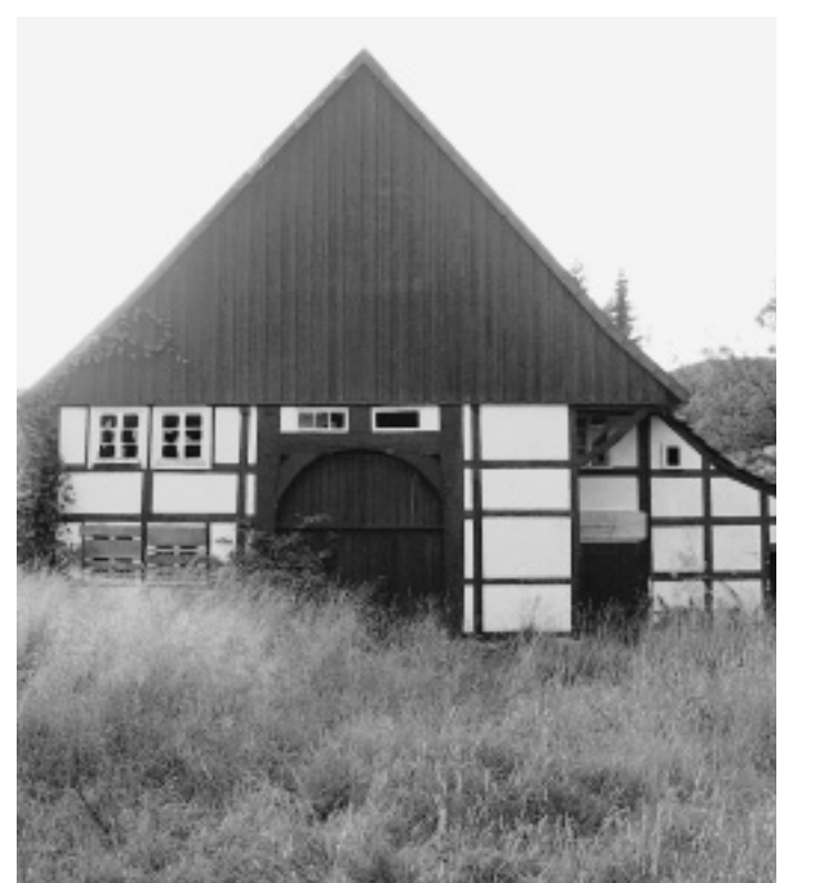
„Ein Liebhaber hat sich gefunden“: Das alte Hofgebäude soll abgetragen und an anderer Stelle neu errichtet werden. FOTOS: BAT
